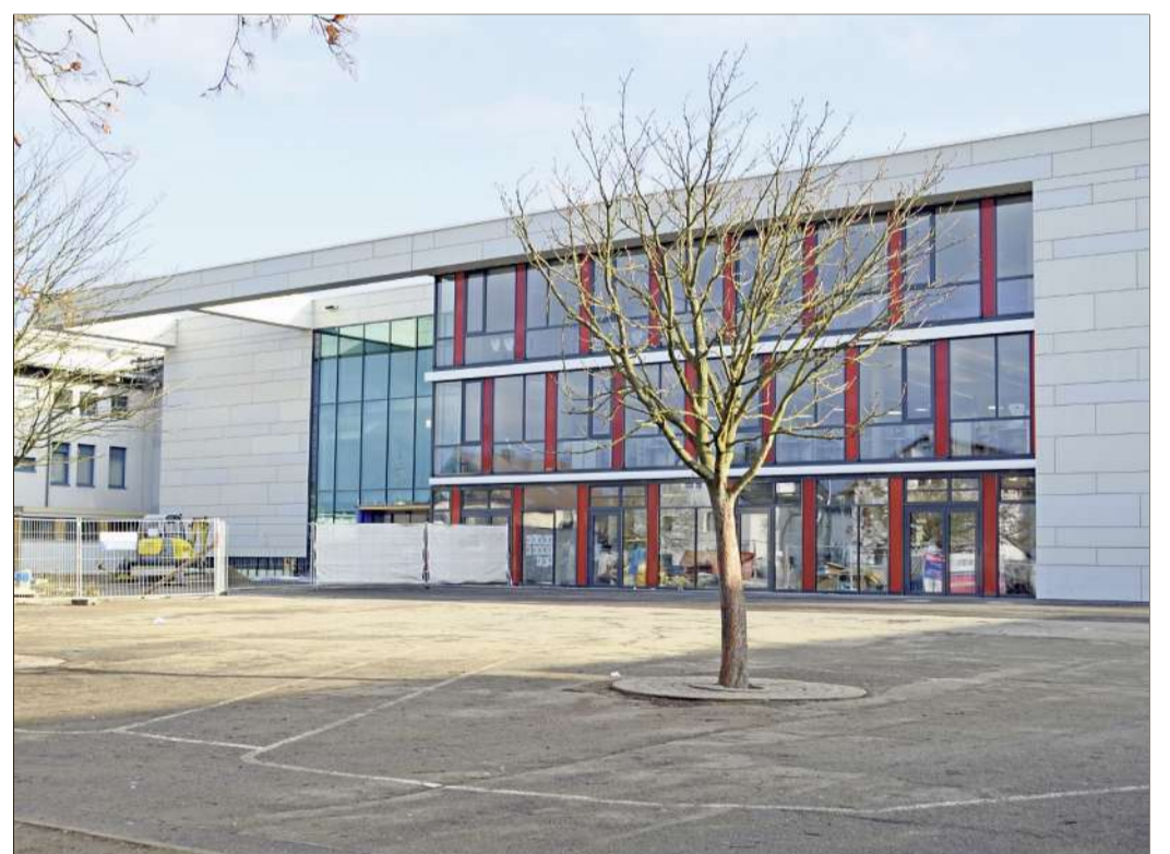
Die Instandsetzung der Hans-Thoma-Gemeinschaftsschule ist in vollem Gange. Sie soll durch das neue Projekt besonders nachhaltig saniert werden. Foto: Archiv/Gangl
